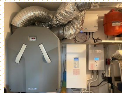
Elektrische ketels (naast WTW)
