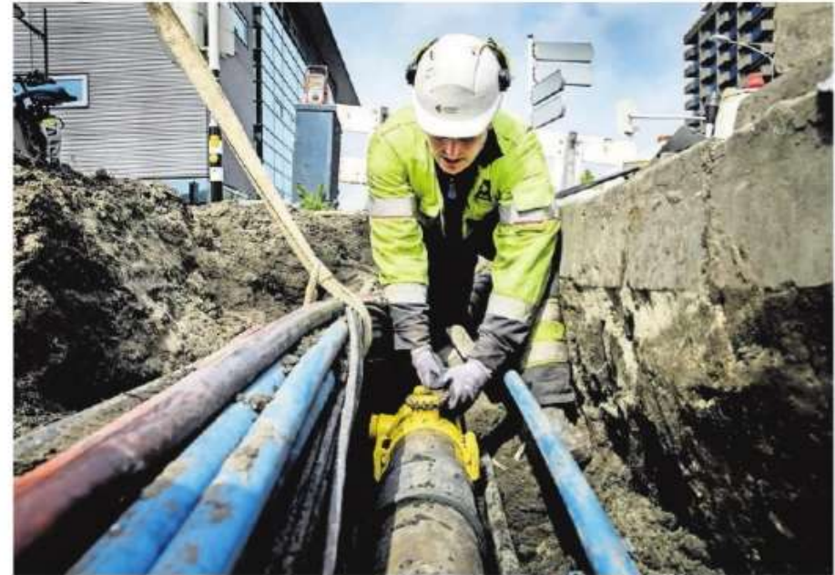
▲ Medewerker van Enexis legt nieuwe dikke stroomkabels. FOTO ENEXIS
